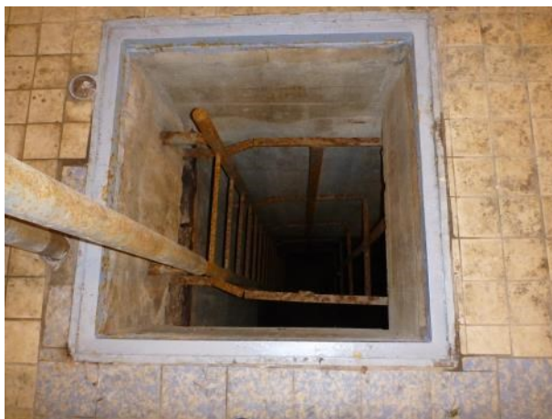
Průlez podlahou strojovny na 735,85 m n.m. a žebřík
