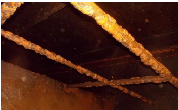
Stávající stav zábradlí v šachtě
